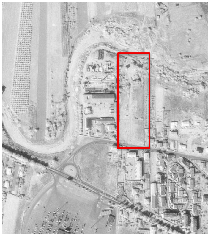
Situation du secteur en 1973 : la parcelle est à l'interface entre un tissu résidentiel (sud et sud-est) et de l'activité économique (Ouest)
