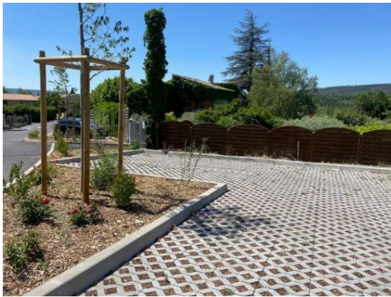
Exemple de parking perméable
