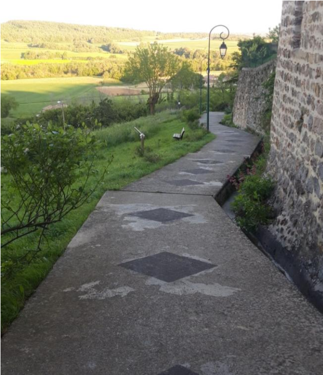
Cheminement sans obstacle à l'écoulement de l'eau
