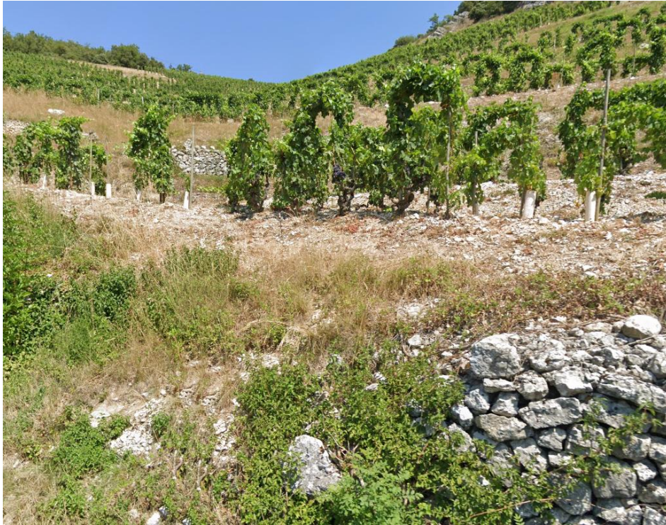
Terrasses agricoles et murets en pierre sèche, Les Royes, Chateaubourg (Google Maps, août 2019)
