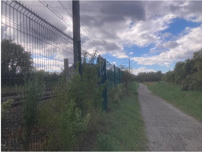
Grillage le long de la voie ferrée à Cornas (MTDA, Octobre 2024)
