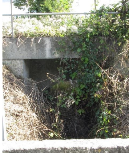
Passage sous la voie ferrée à Charmes-sur-Rhône (MTDA, Octobre 2024)
