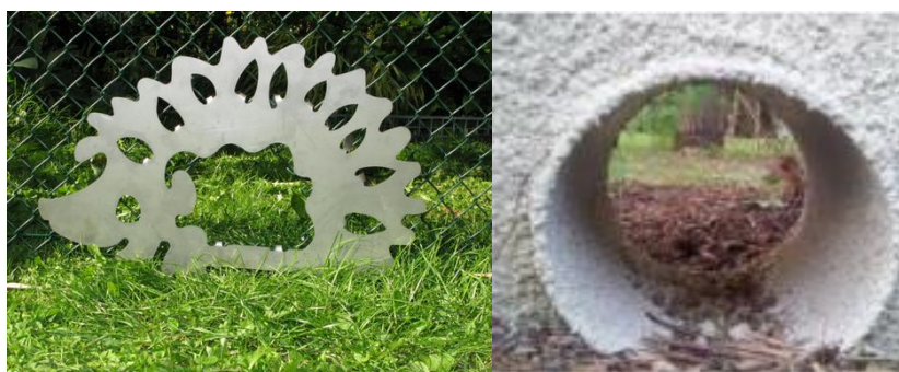
Figure 3 : Exemples d'ouvertures dans un grillage et un muret, prévues pour le passage de la petite faune
