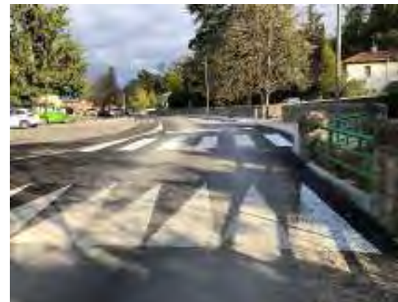
Travaux à Saint-Péray
