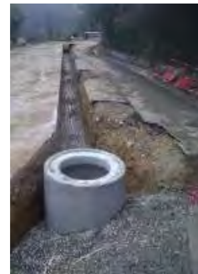
Travaux de réfection à Saint-Georges-les-Bains
