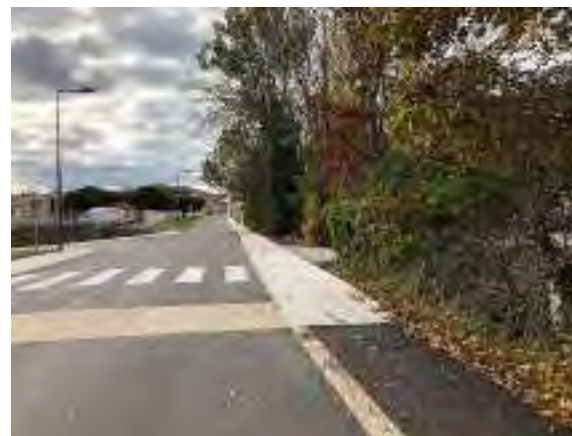
Travaux à Alboussière
