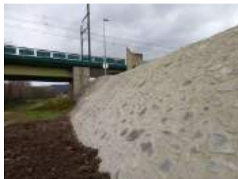
Digue rive gauche entre le pont ferré et le pont routier
