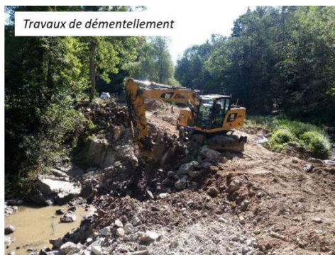
Fin travaux – Vue du barrage démantelé
