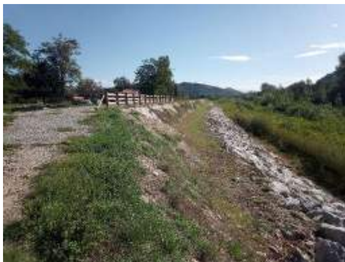
Digue rive gauche après entretien d'août 2022
