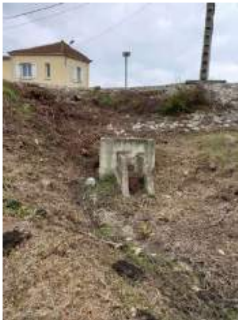
Avant les travaux
